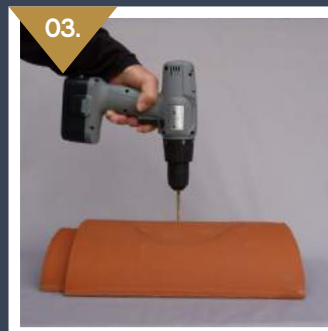
03. Bohren mit Steinbohrer 6 bzw. 10 mm
